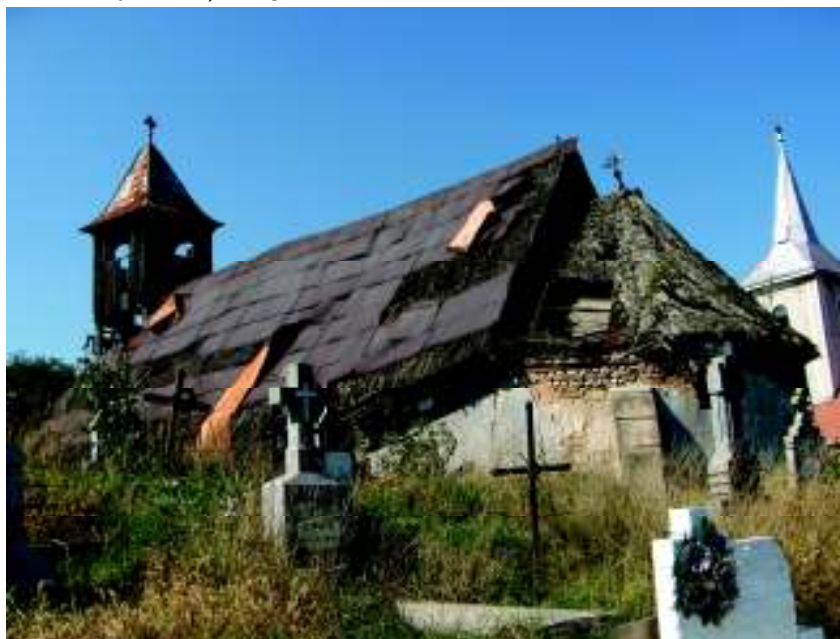
Fig. 1. Biserica de lemn din Hăpria; fotografie anterioară cu câteva săptămâni momentului demolării.
